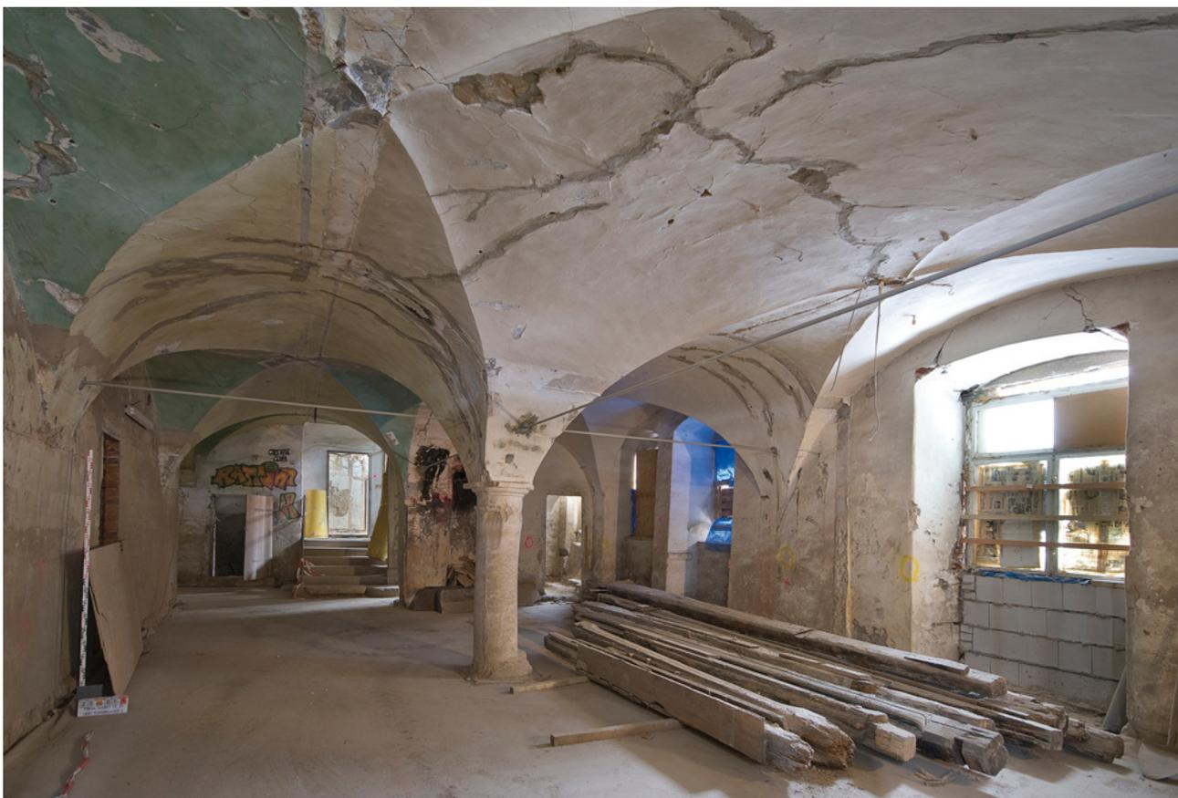
Abb. 4: Eingangshalle, Renaissancegewölbe über toskanischer Säule, Blick nach Norden auf erhöht liegenden Eingang zur Hauskapelle
