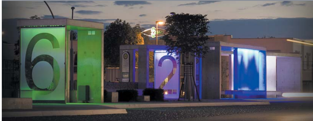
Neubau Zentraler Omnibusbahnhof in Pirna
